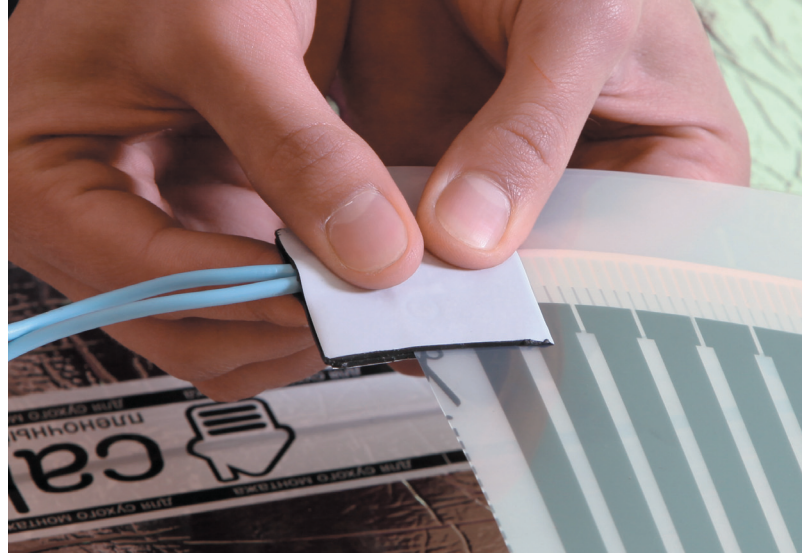
Рис. 19. Установка верхнего листа изоляции
