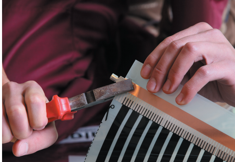
Рис. 10. Крепление контактного зажима к термопленке
